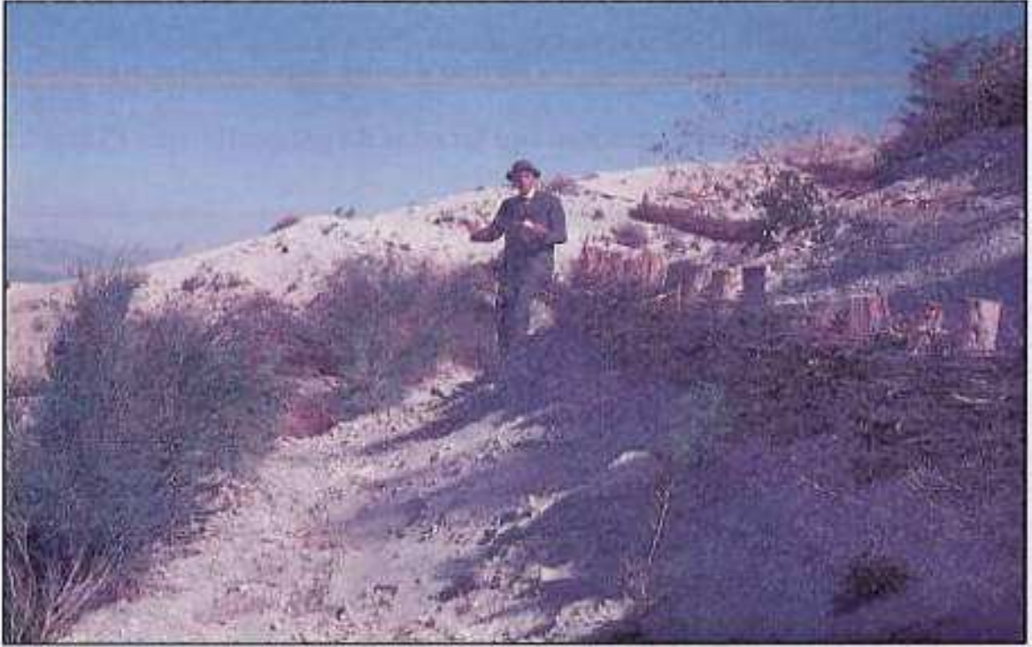
Şekil 22. Burdur Yöresinde çok eğimli arazide, erozyon eğilimi yüksek marn topraklarındaki teras dikimlerinde terasların çitler ve çalılarla desteklenmesi. Foto: Çepel - 1965
