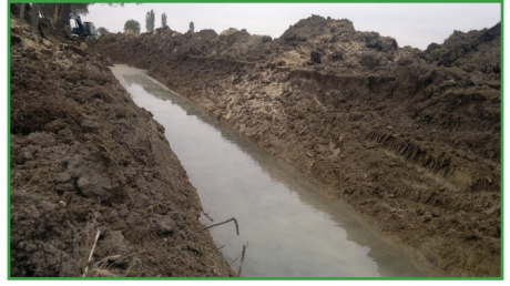
Şekil 7. Kınık'ta taban suyu yüksek meralarda açık drenji kanalı çalışması
