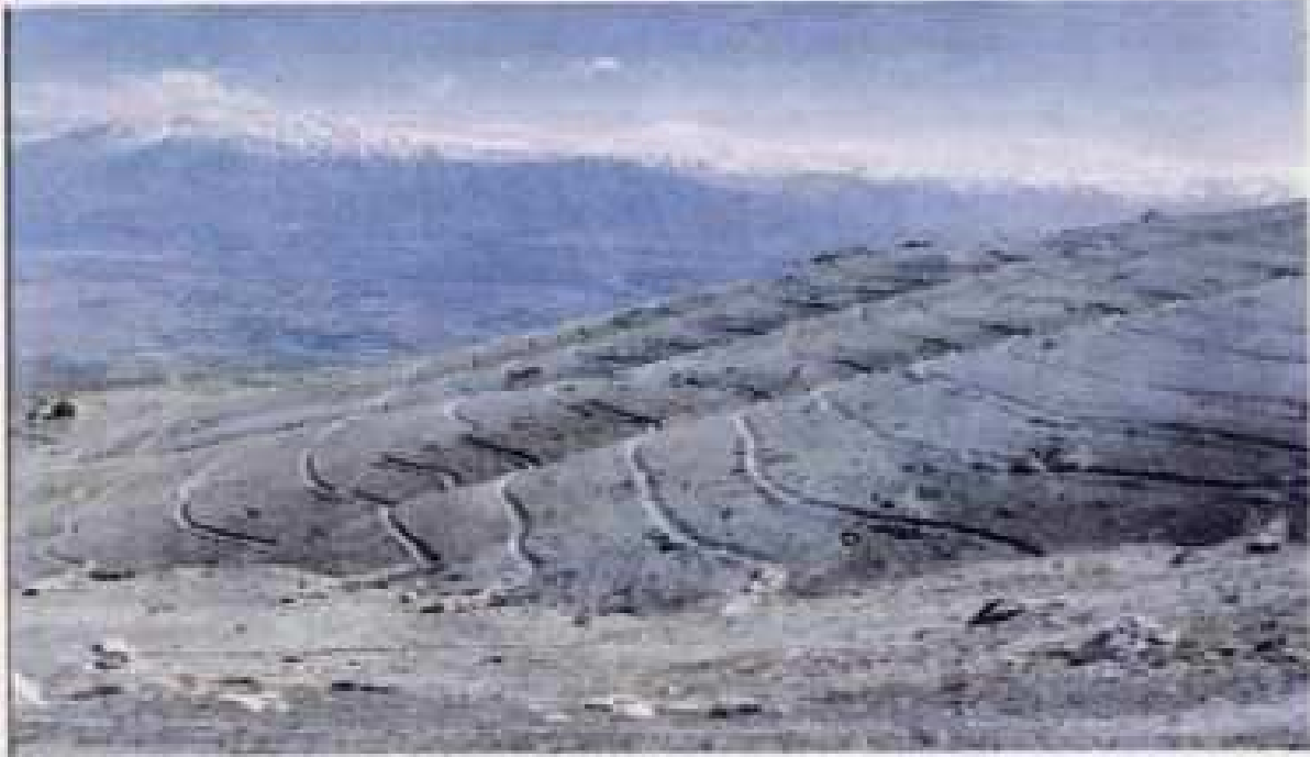
Resim 14. Yamaç arazide erozyonu durdurmak için yapılan seki teraslar (Orman Bakanlığı Arşivi, Foto Çelikkol).
