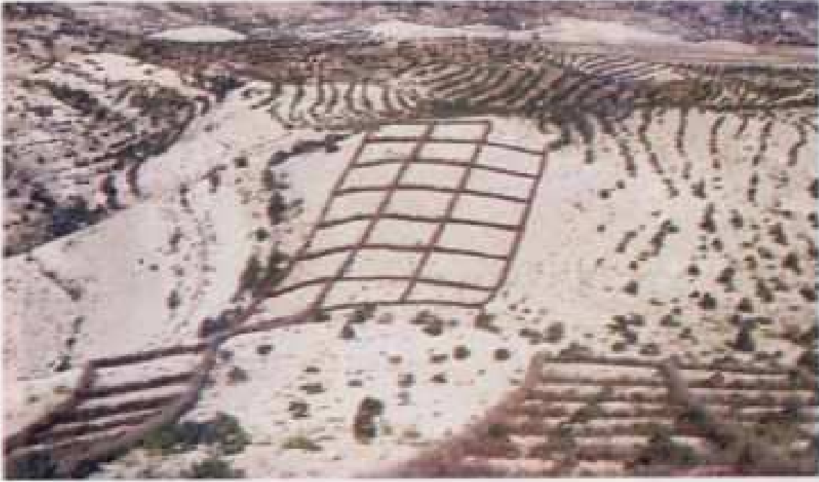
Resim 23.Rüzgarın çok yönlü estiği Burdur mara erozyon alanında kapalı sistem olarak yapılmış rüzgar perdeleri (Orman Bakanlığı arşivi 1985).
