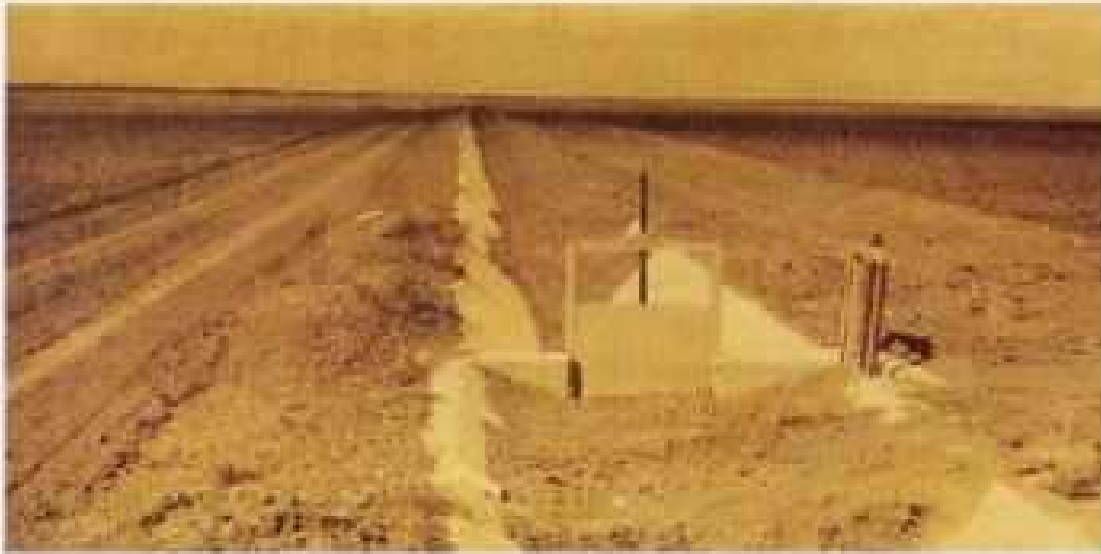
Rüzgar erozyonu nedeniyle toprakla dolan sulama kanalları (Konya-Çumra)
